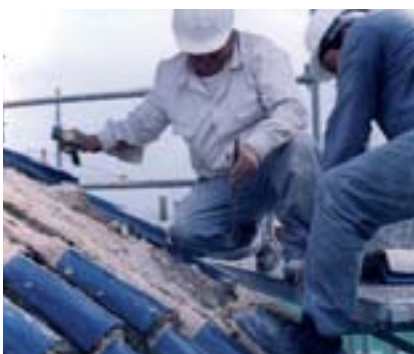
Treballs de restauració de la cúpula de l'ermita de la Mare de Déu de la Vallivana.
