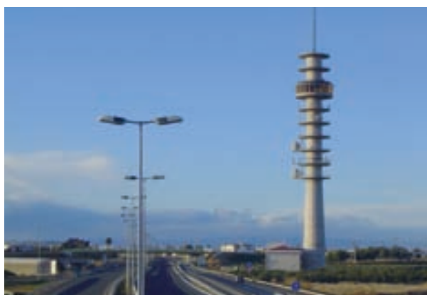
Distribuidor Comarcal Sud.
